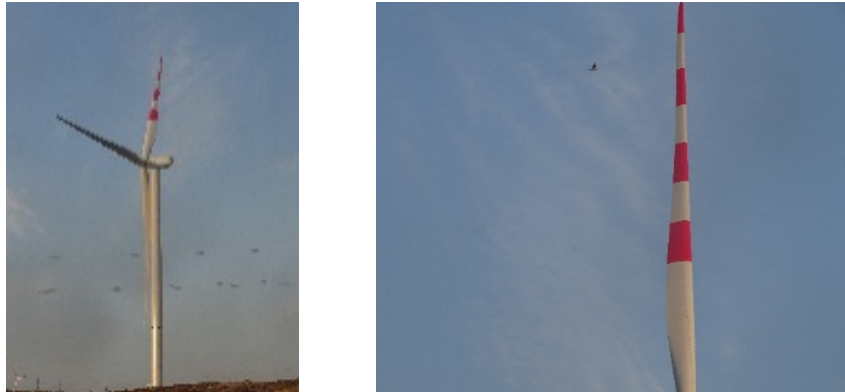
Fotografía 1. Ejemplo de palas pintadas con cuatro bandas rojas en una de las palas del aerogenerador.
